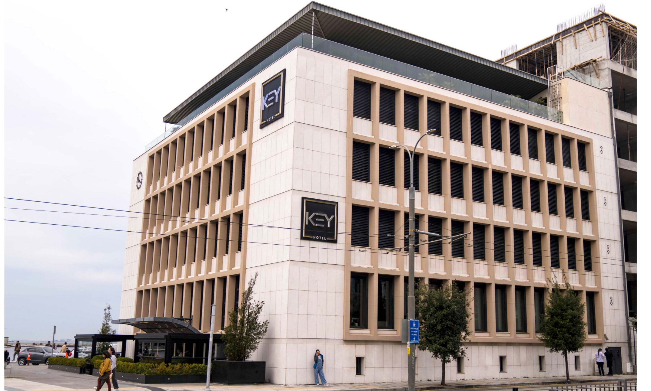
Figür 13.1. Atatürk Caddesi yönünden Eski Merkez Bankası binasının günümüzdeki görünümü (Kaynak: İzMiras, 2023).
