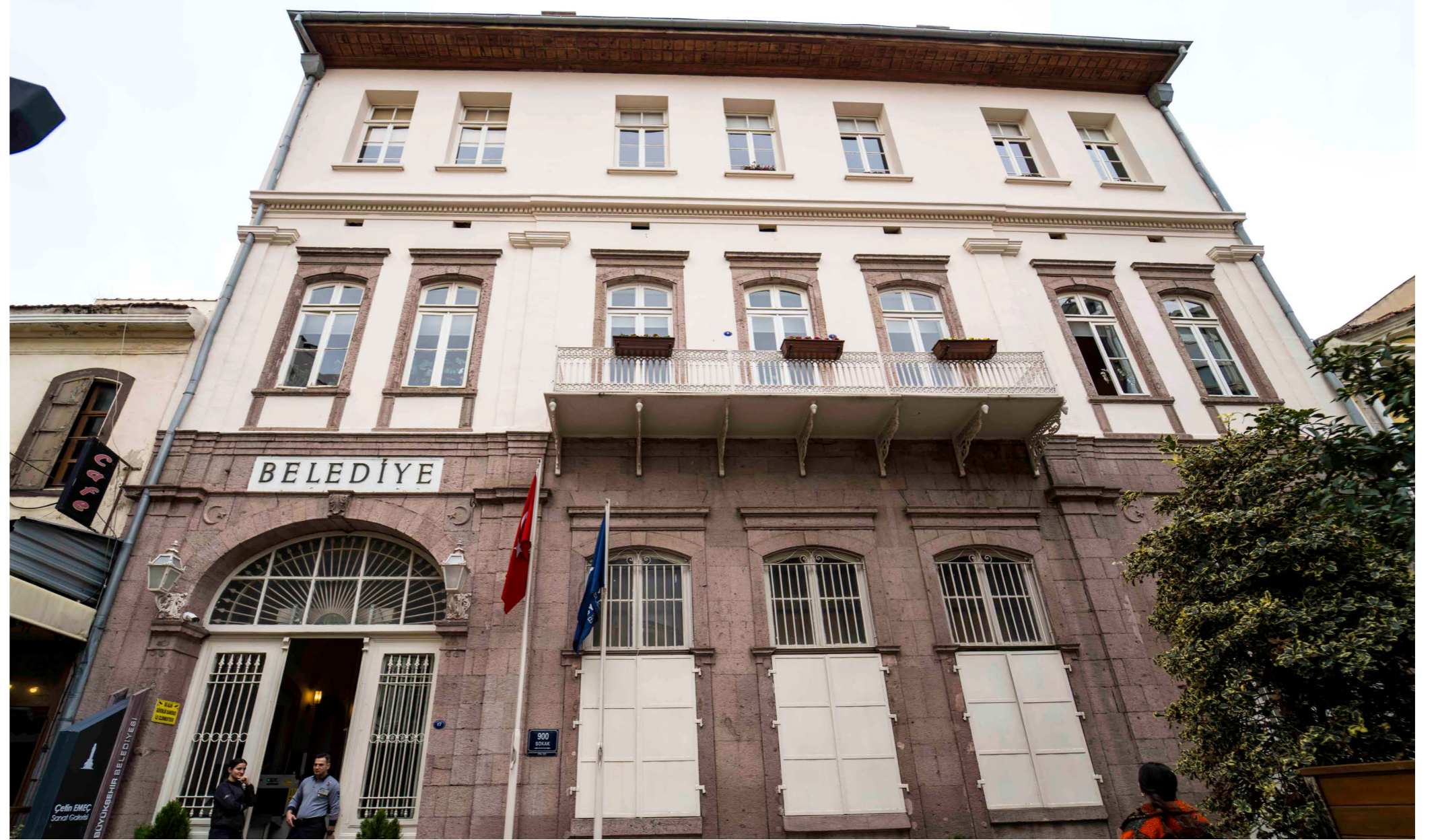
Figür 12.1. Eski Belediye binasının kuzey cephesinin günümüzdeki genel görünümü (Kaynak: İzMiras, 2023).
