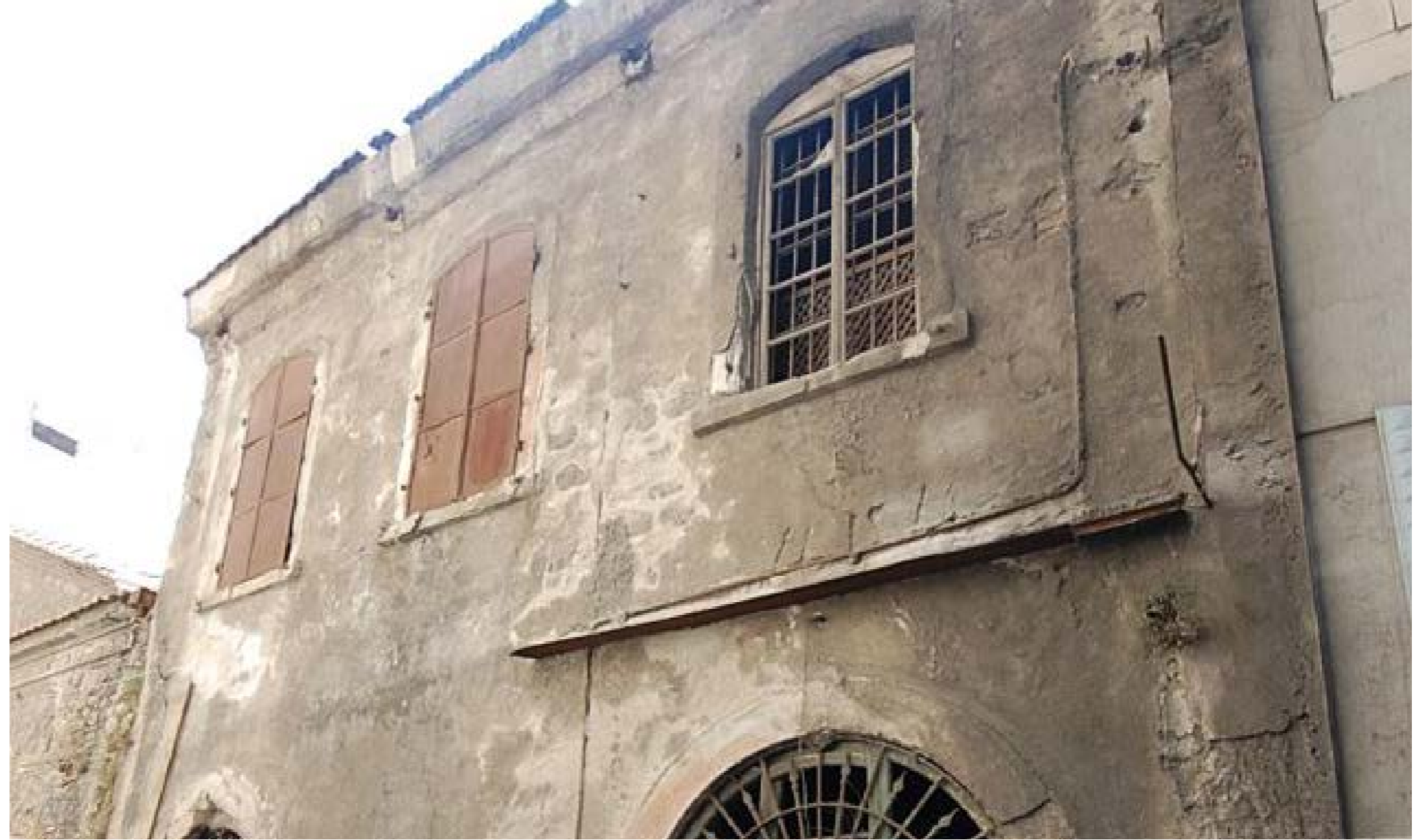
Figür 25.1. Romanya Konsolosluğu binasının 1347 sokağa bakan cephesinin 2007 yılındaki genel görünümü (Kaynak: İzmir Büyükşehir Belediyesi, İzmir Kent Rehberi).
