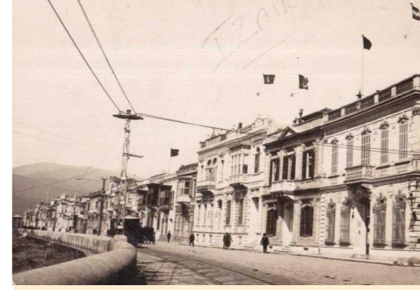
Figür 23.3. Alman konsolosluk binasının cephesindeki değişiklikler yapılmadan önceki görünümü (Kaynak: facebook.com, "Küllerin Doğan Şehir İzmir", 15.01.2024).
