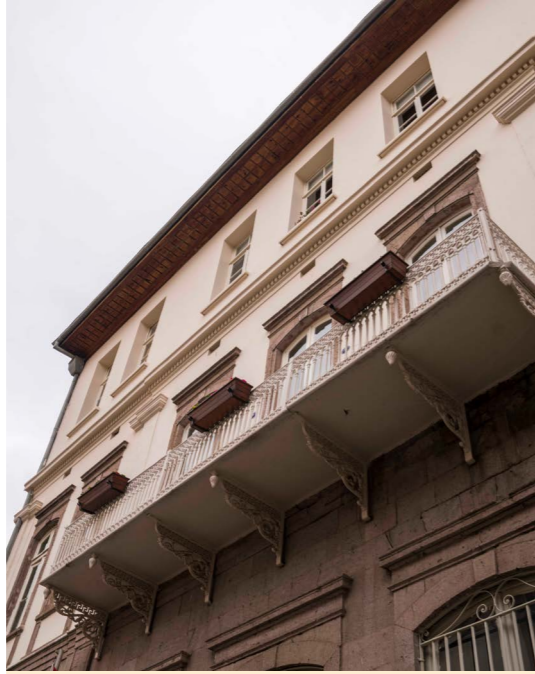
Figür 12.1. Eski Belediye binasının kuzey cephesinin günümüzdeki genel görünümü (Kaynak: İzMiras, 2023).
