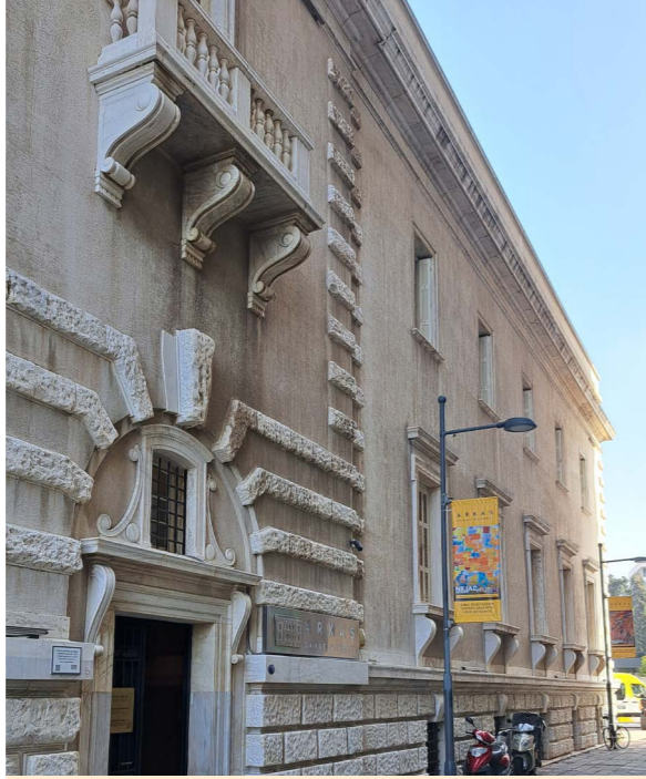
Figür 21.2. Fransız Konsolosluk Binasının Fransa sokağına (1380 sokak) bakan cephesinin günümüzdeki genel görünümü (Kaynak: İzMiras, 2023).
