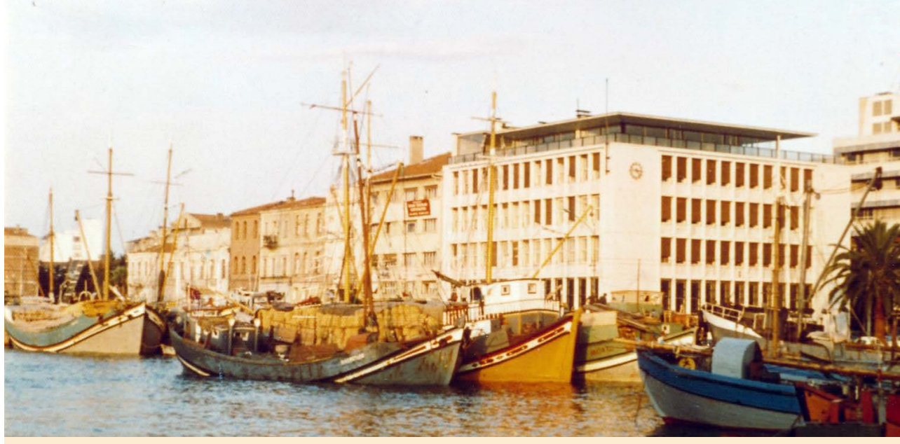
Figür 13.2. Bina'nın Merkez Bankası Şubesi olarak kullanıldığı dönemden genel görünümü (Kaynak: facebook.com, "Küllerin Doğan Şehir İzmir", 15.01.2024).
