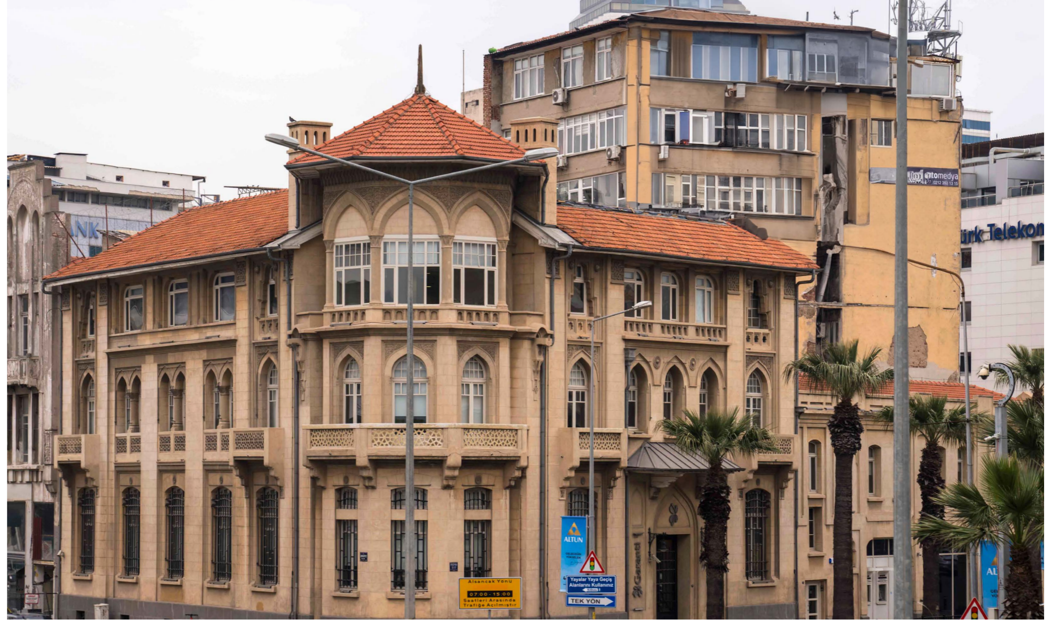
Figür 3.1. Osmanlı Bankası'nın Fevzipaşa Bulvarı'na bakan cephesinin günümüzdeki genel görünümü (Kaynak: İzMiras, 2023).
