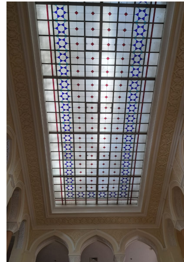
Figür 3.3. Osmanlı Bankası'nın galeri boşluğunun vitray camdan oluşan tavanının günümüzdeki genel görünümü. (Kaynak: İzMiras, 2023).
